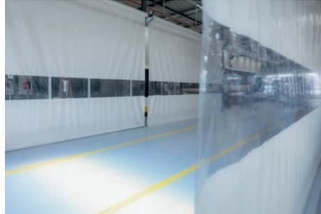
Durchsicht: Die rollbaren Trennwände können mit «Fenstern» versehen werden, damit viel Licht durchkommt
